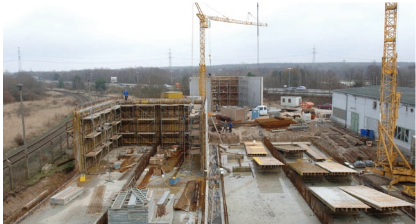
An der Pampower Straße entsteht die neue Biogasanlage.
