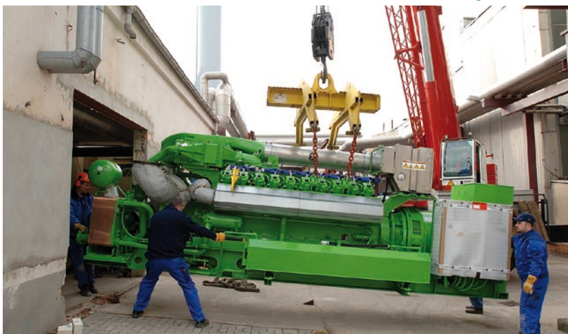
Das Gasgemisch wird einem Verbrennungsmotor zugeführt, der einen Generator antreibt. Der so produzierte Strom wird ins Netz eingespeist.
